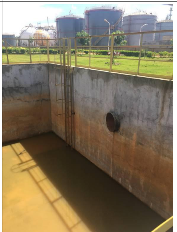
照片 6 厂区事故应急池
