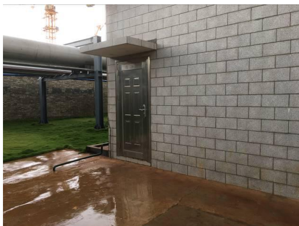
图 11-2 危险废物暂存库
